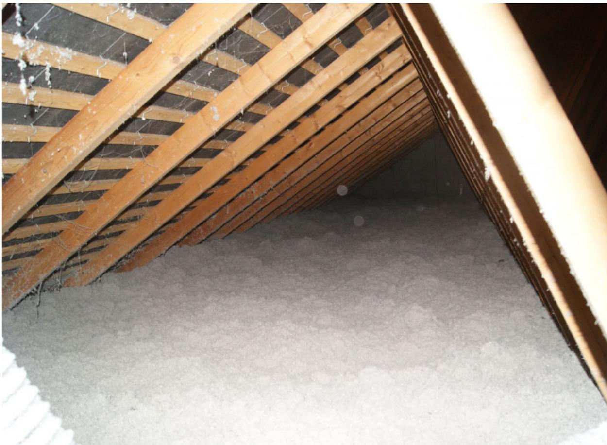
*Dépose de la laine de verre existante , dépose de la trappe d'accès , pour y intégrer une trappe isolante (Résistance thermique = 7.5) et étanche a l'air . Soufflage de la ouate de cellulose grâce a notre cardeuse restée a l'extérieur de la maison (passage des tuyaux par la toitures) , épaisseur 35 cm pour une résistance thermique R=7 . Travaux éligible au crédit d'impôt .*
