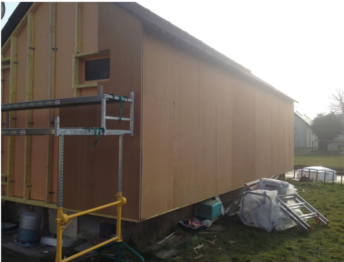
*Isolation en matériaux naturels , Création d'une ossature bois rapportée sur le mur existant , soufflage de ouate de cellulose dans l'ossature 100mm puis recouvrement de l'ossature en fibre de bois de 60 mm rainuré bouveté (Fibre Pare pluie) , Résistance Thermique de l'ensemble = 3.85 . Ensemble de l'isolation en matériaux naturels puis finition en bardage Pvc .*
