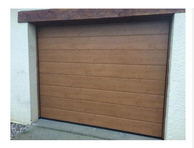
Rénovation sur pavillon : remplacement de la porte de garage , mise en place d'une porte Hormann isolante avec panneaux en acier , épaisseur 42mm , imitation bois (winchester) . Motorisation Somfy a commande radio dexxo pro .
