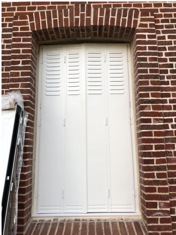
*Pose de persiennes métallique spécifique pour la protection contre l'effraction . Remplacement de tapées existantes par des tapées aluminium .*
